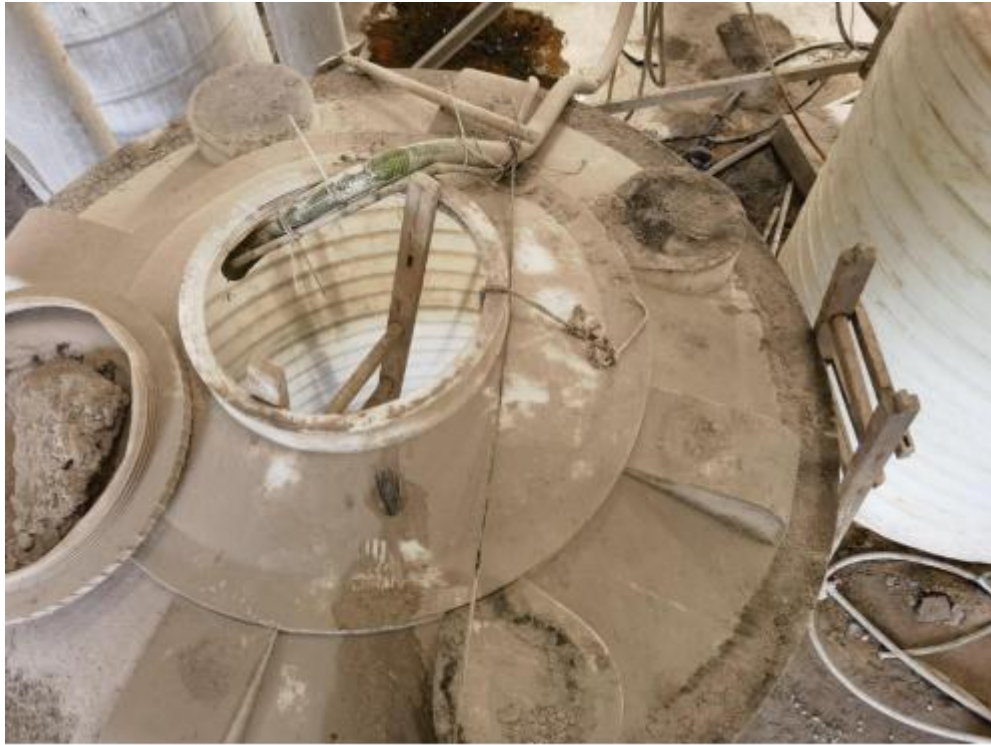
图 6 事故桶照片（顶部进料口）
